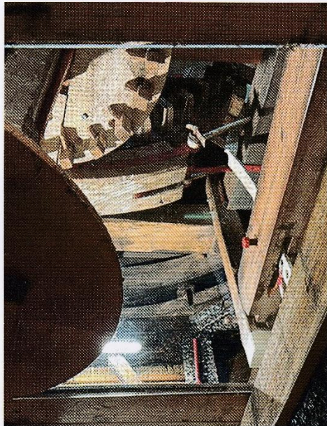
Zicht op de kap door het plexiglas.
