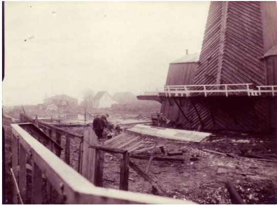
De binnenroede wordt opgehekt, waarna de delen genummerd worden, en weer gemonteerd worden nadat de roede is gestoken. Die scheerhouten vervangen de normaal gebruikte kluften op de voorzijde van de heklatten. Op de foto hierboven zijn de scheerhouten ook weer aangebracht. De hoek tussen de buitenste heklat en de stand van het bord op de voorzoom bedraagt ca. 45° en er is geen kluft aangebracht. Op de achtergrond staan het molenaarshuisje en de elektrische zagerij.
