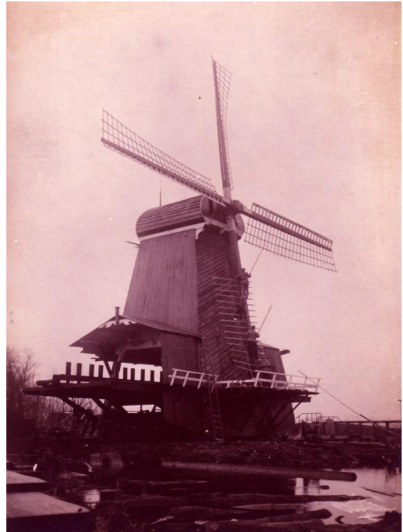
De Eenhoorn krijgt een geheel nieuw gevlucht. De molenmakers zijn bijna klaar met ophekken. De molen is een hele tijd voorzien van lage baliehekjes op de zijanten van het schavot.
