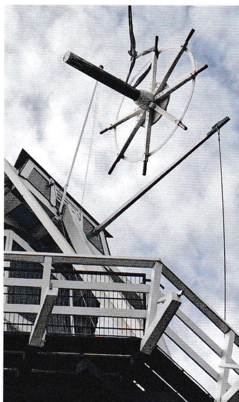
Het kruirad wordt van de stelling getakeld.
